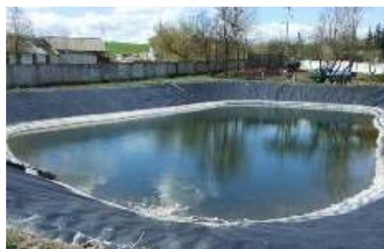
Водоем заливается на 1/3 водой, чтобы она своим давлением равномерно распределила мембрану по дну и стенам водоема. Затем водоем заполняется полностью.
